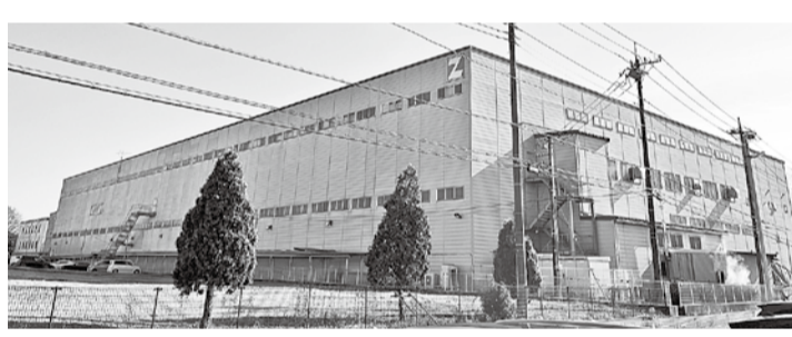
坂東市物流施設のリニューアル工事現場
