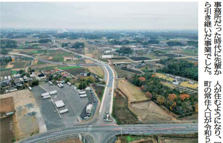
▲坂東ICのアクセス道路である結城坂東線バイパス
